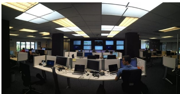
Imagen 1.8. Aspecto de una de las salas de un SOC.
